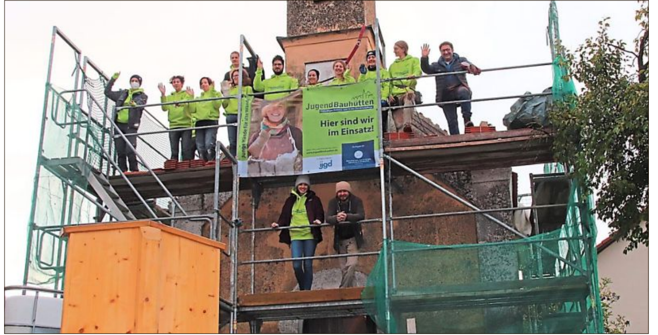
Gruppenbild mit dem Landtagsabgeordneten Tobias Gotthard (oben rechts) und Stefan Aichner (Leiter der Jugendbauhütte Regensburg) auf dem Baugerüst. Fotos: Urte Scheubeck
